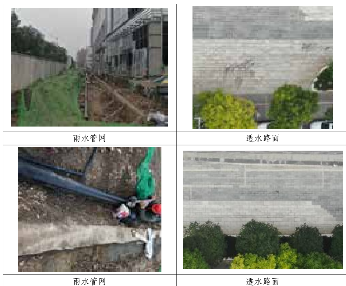
图 4-1 水土保持工程措施实施情况
