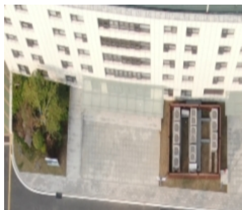
透水路面（2021 年 10 月）
