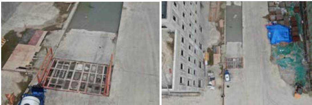
洗车平台及临时排水沟（2019.12.6）
