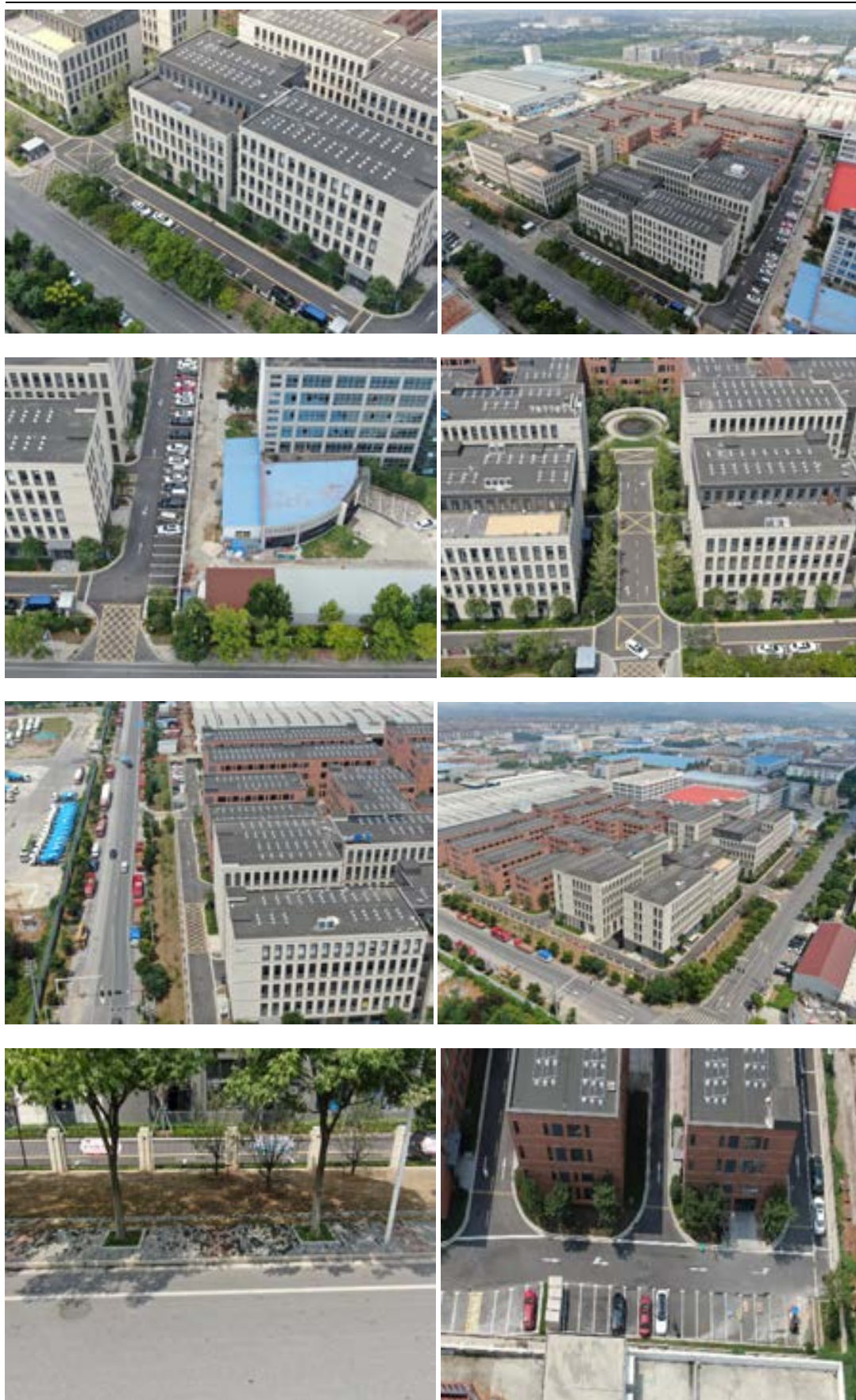
项目完工后照片（2021.8.30）
