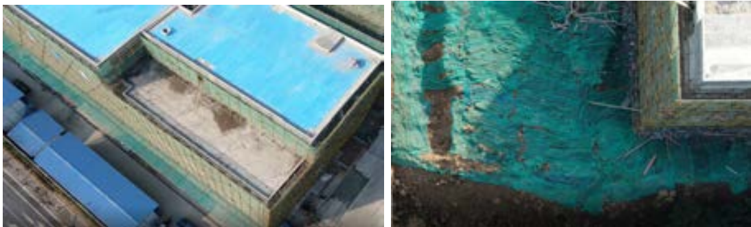
施工生产生活区及临时堆土区（2019.12.6）
