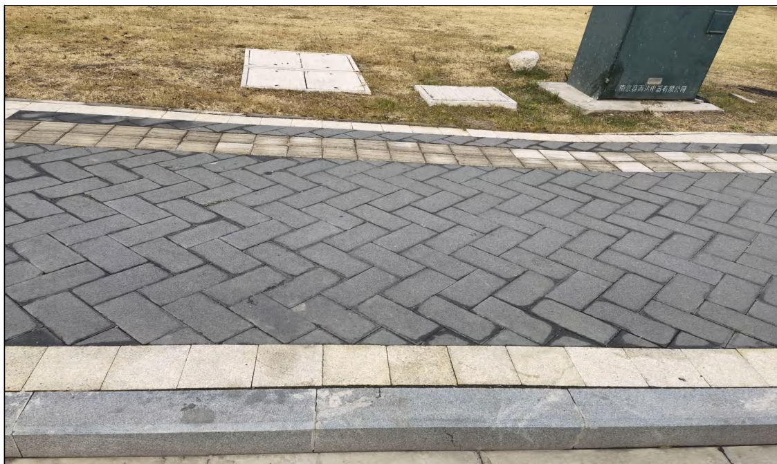
人行道透水铺装（2022 年 6 月 28 日）
